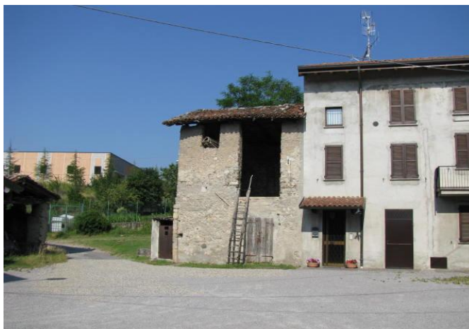
PROSPETTO SU CORTE INTERNA
